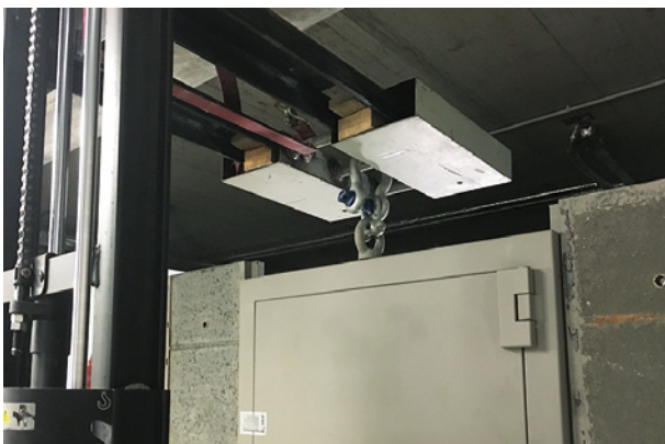
Setzen der Wertschutztür im Raum
