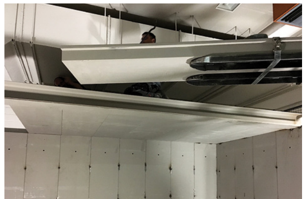
Einbau Deckenelemente
