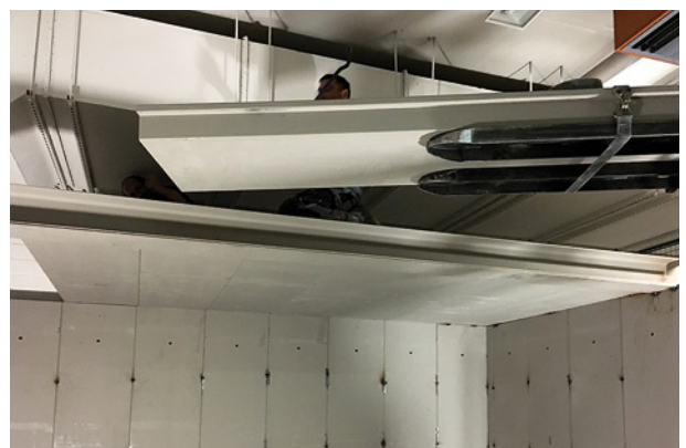
Einbau Deckenelemente
